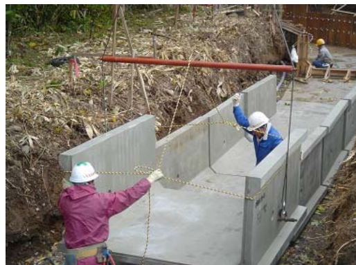
Блоки для прокладки канала
